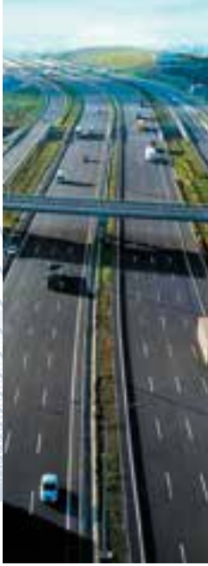
KUZEY MARMARA OTOYOLU
