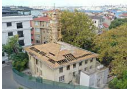
İMRAHOR CAMİİ RESTORASYONU
