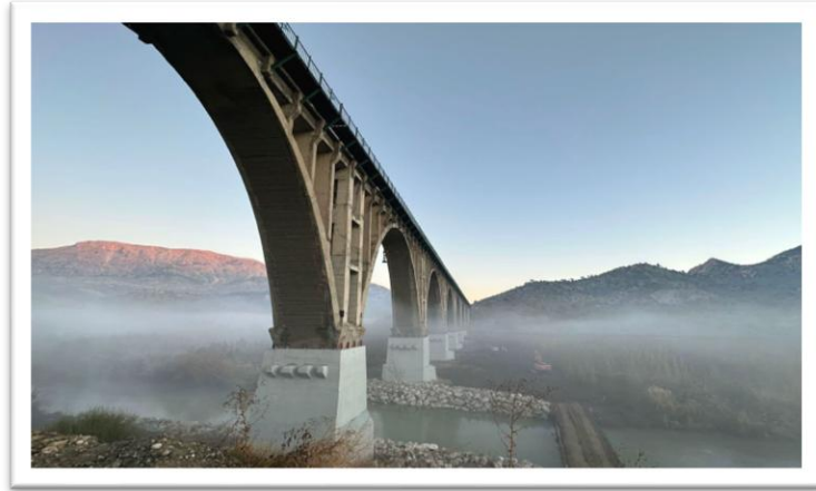
Onarılan Demiryolu Köprüsü (Alman Köprüsü), Adıyaman
